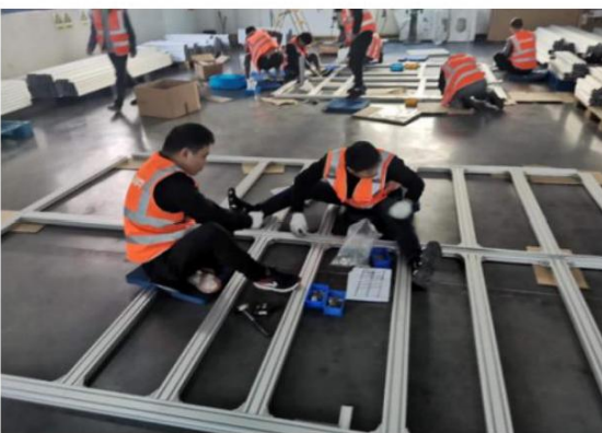
(项目现场-设备机构搭建)
